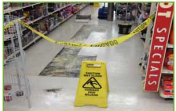
...което води до отлепване на плочите
