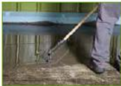
5. При обработката на големи площи използвайте Грапа за замазки КЪОСТЕР за тази цел.
