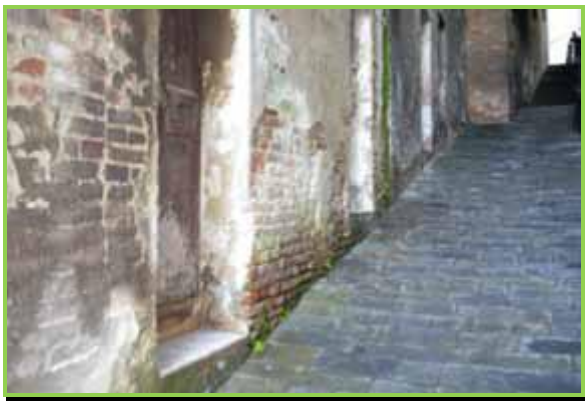
Разрушаване на мазилката и фугите.
