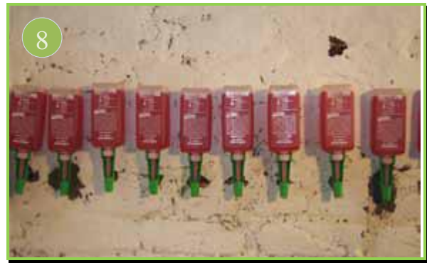
Инжектирането без налягане на KÖSTER Crisin ®76 в зидарията започва веднага след инсталирането на патронниците.
