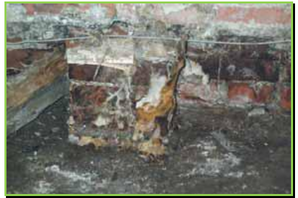
Развитие на мухъл и нарушаване целостта на конструкцията.
